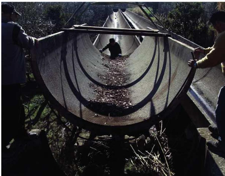
Lavori di sostituzione di una canaletta crollata per vetustà.
