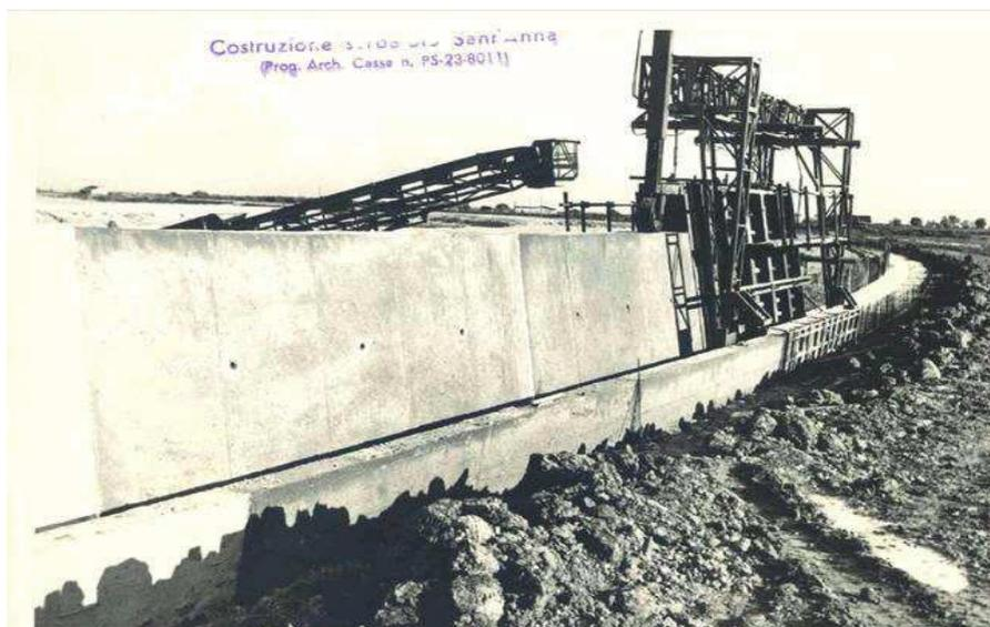
*Muro alla base della diga con cunetta di raccolta delle acque provenienti dal rilevato. Particolare della cassaforma mobile per la realizzazione del manufatto.*
