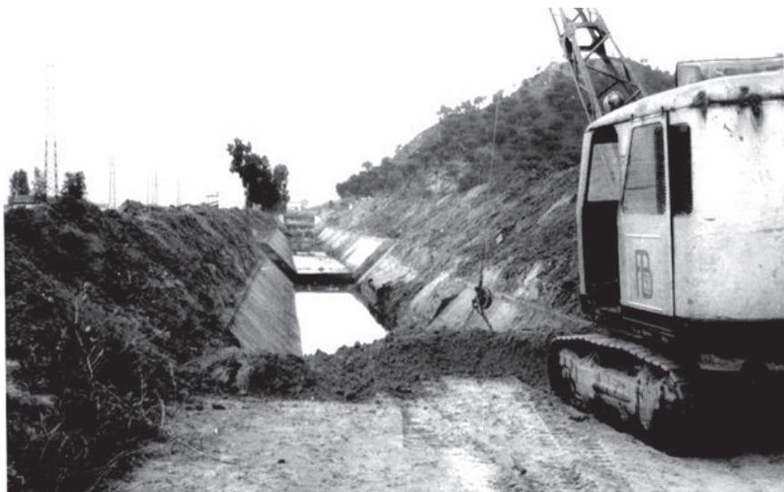
*Lavori di rimozione con escavatore a fune di una notevole quantità di materiale ingombrante che occlude la sezione del canale.*
