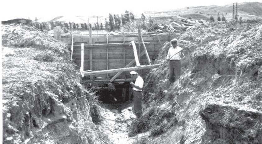
*Anni 50, piana di Crotone. Momento di una misurazione da parte di addetti dell'Ente Bonifica, nel corso della realizzazione di una "tombinatura" di un canale, onde consentirne l'attraversamento (ponticello).*
