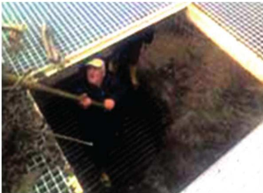
**U**n momento dell'Operazione di ripulitura delle **Griglie dei pozzetti di presa idrica**.
