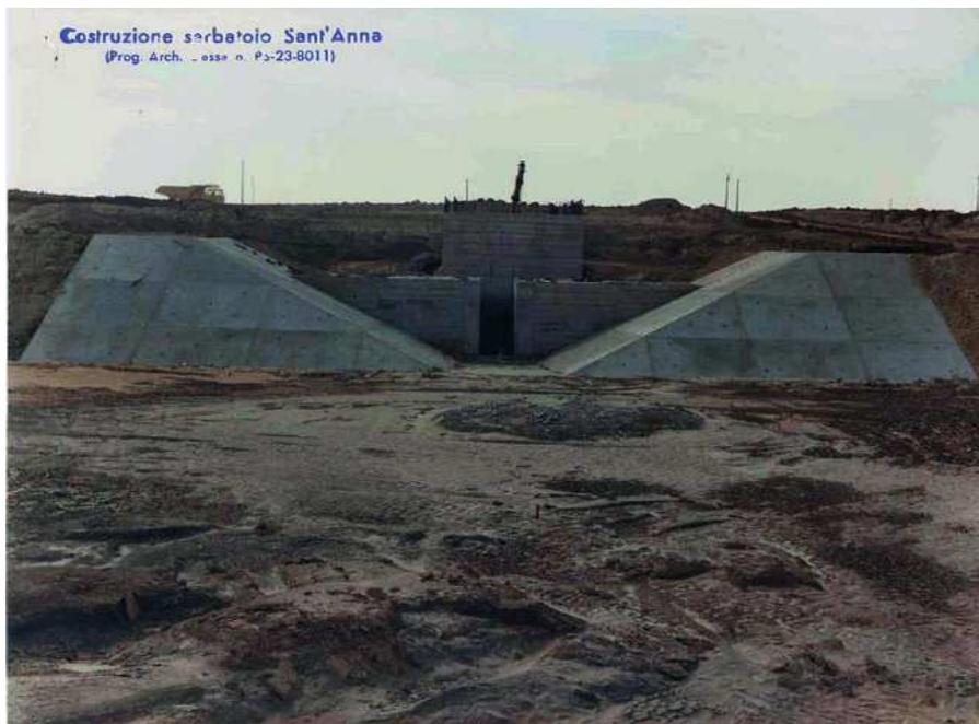
*Particolare della camera di manovra interna alla diga in corso di completamento*
