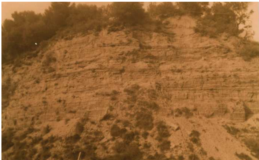
Immag. 10 - Colline dell'Odighitria 1980 Particolare della pendice in frana (altezza media del fronte c.a. 15 mt.) creata sul versante Est del "Monte Tabor" dal prelievo di inerti per la costruzione di un tratto della SS 106, Taranto- Reggio, negli anni 70 (visibile in foto) - Foto M. Dottore
