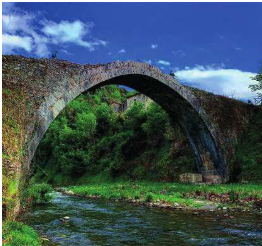
Fiume del Savuto ed il ponte sull'Antica Consolare Romana.
