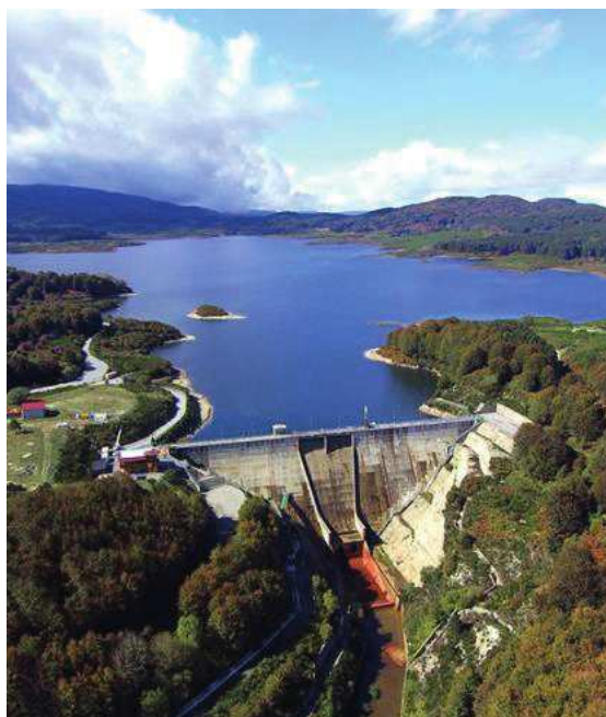
Diga di Monte Mamone sul Fiume Alaco.
