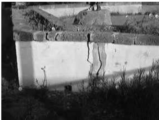
*Cirò, ”Monte Tabor”. Segmento del muro perimetrale, sul versante Est del colle dove sorge il “ Centro Assistenziale” dell’Odighitria. Vistose lesioni causate da fenomeni di assestamento del suolo.*
