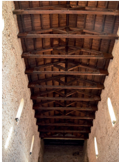
Abbazia San Giovanni in Fiore - soffitto in legno con capriate a vista
