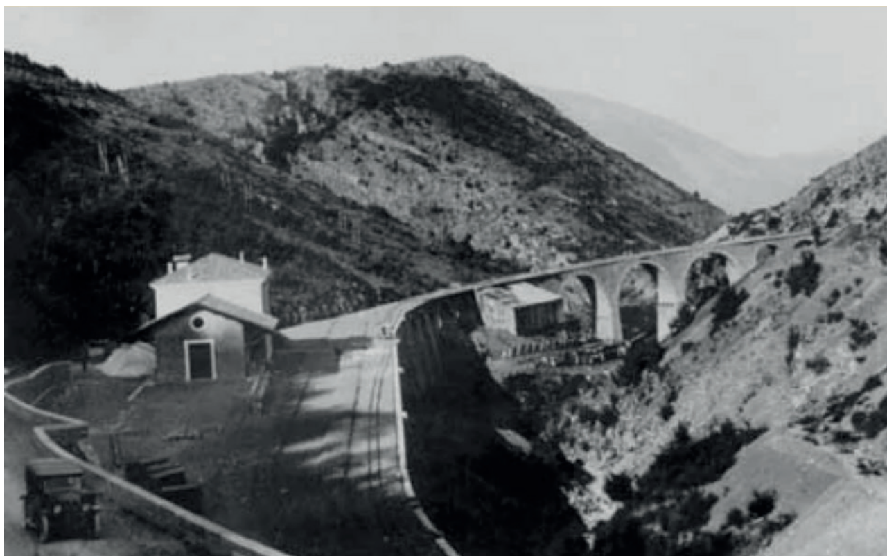
Cantiere negli anni 20
