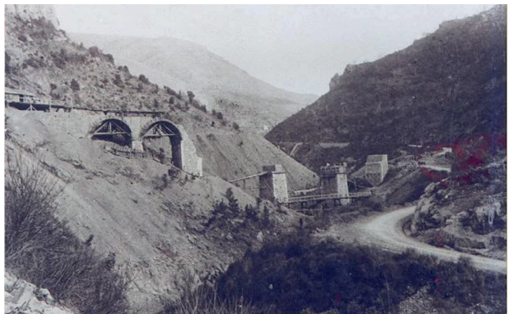
La fase di costruzione del viadotto della stazione di Lauria negli anni 20
