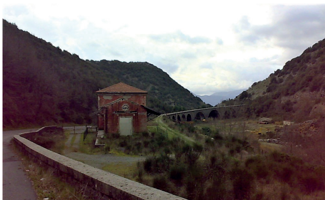
Stazione di Lauria dismessa e abbandonata.
