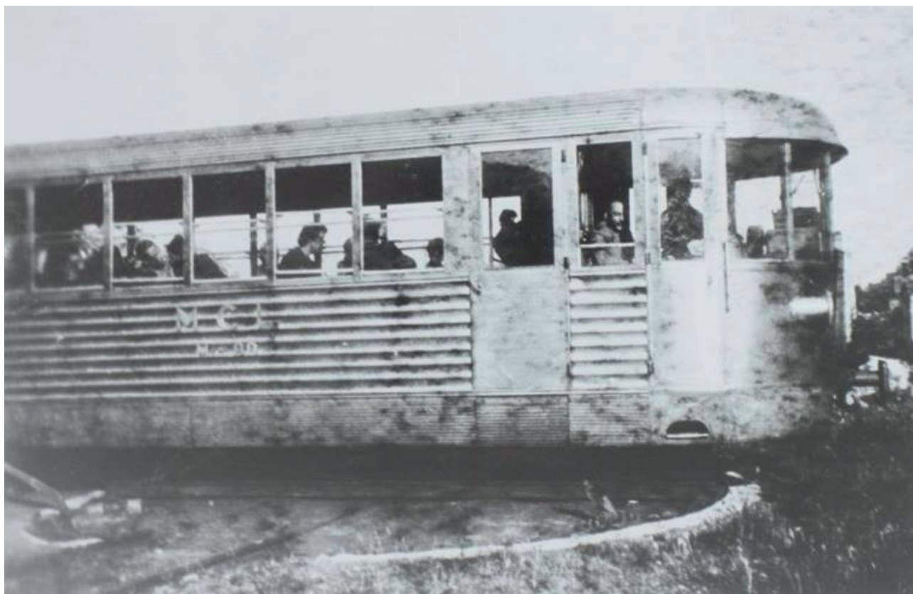
Giugno 1945, la "littorina" M1c n.88, con tutti i viaggiatori a bordo, viene girata sulla piattaforma di Bivio Latronico in modo che possa proseguire il viaggio in retromarcia fino all'uscita della galleria di Lauria (Foto Luigi Saccomanno, archivio Enrico Saccomanno)
